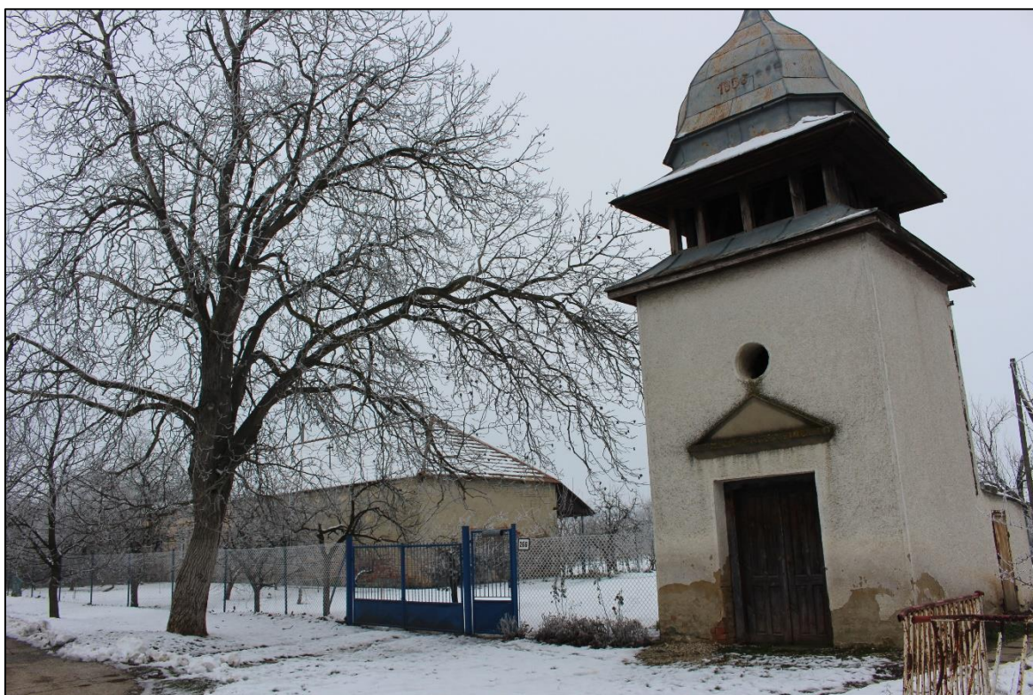
Budova zvonice čaká na svoju rekonštrukciu, december 2017.
